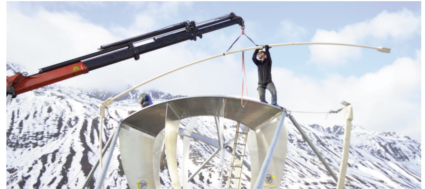
Nella pagina a fianco, prototipo della "nuvola di neve" (Wolke für Neuschnee) durante il lavoro di ricerca di Michael Bacher, CEO di Neuschnee GmbH e committente. Sopra, lavori di costruzione a Obergurgl (Austria). Sotto, dettaglio di uno degli elementi curvati in opera e struttura del modello in scala 1:10.
